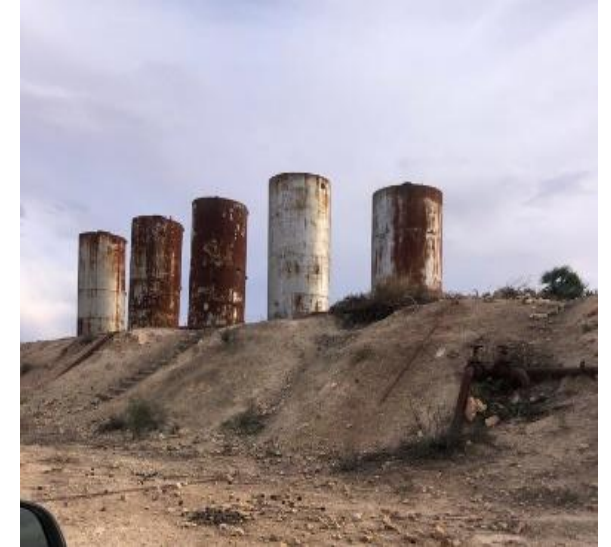
Figure : Bacs de stockage de condensat de 30 m 3
